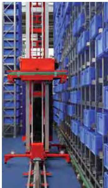
Equipo automatizado transelevador
