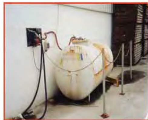
Depósitos sin protección contra golpes en zonas de circulación
