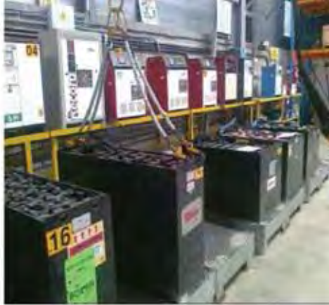
Sala de carga abierta de carretillas elevadoras
