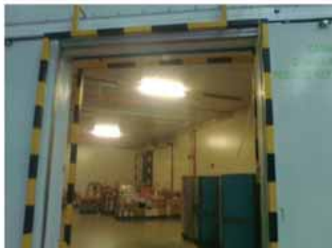
Señalización de gálidos de paso para vehículos automotores
