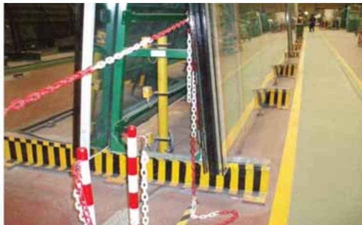
Señalización de la base de los caballetes y delimitación de zonas de paso
