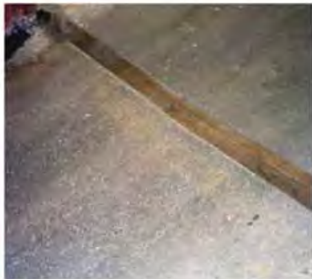
Zonas de paso de carretillas elevadoras con riesgo por acumulación de materiales y ausencia de fijación de las protecciones en el suelo
