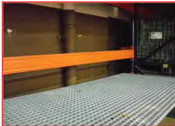
Base portante tipo tramex en la estantería
