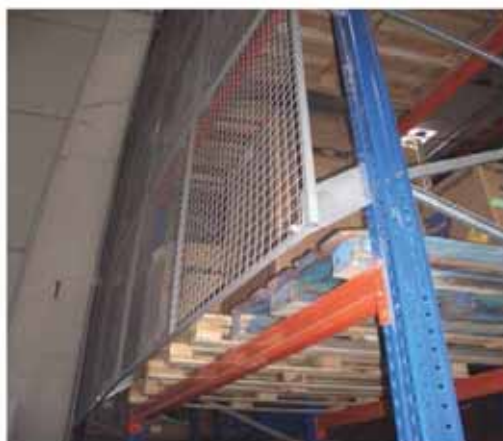
Protección de zona de puesto de trabajo y topes en zonas adyacentes
