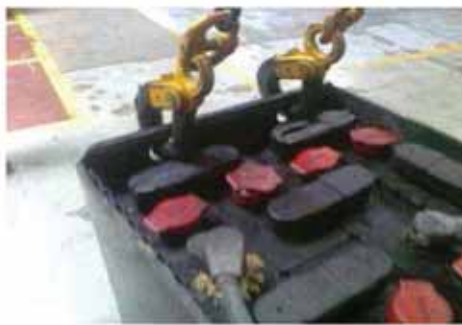
Manipulación de baterías con aparatos elevación
